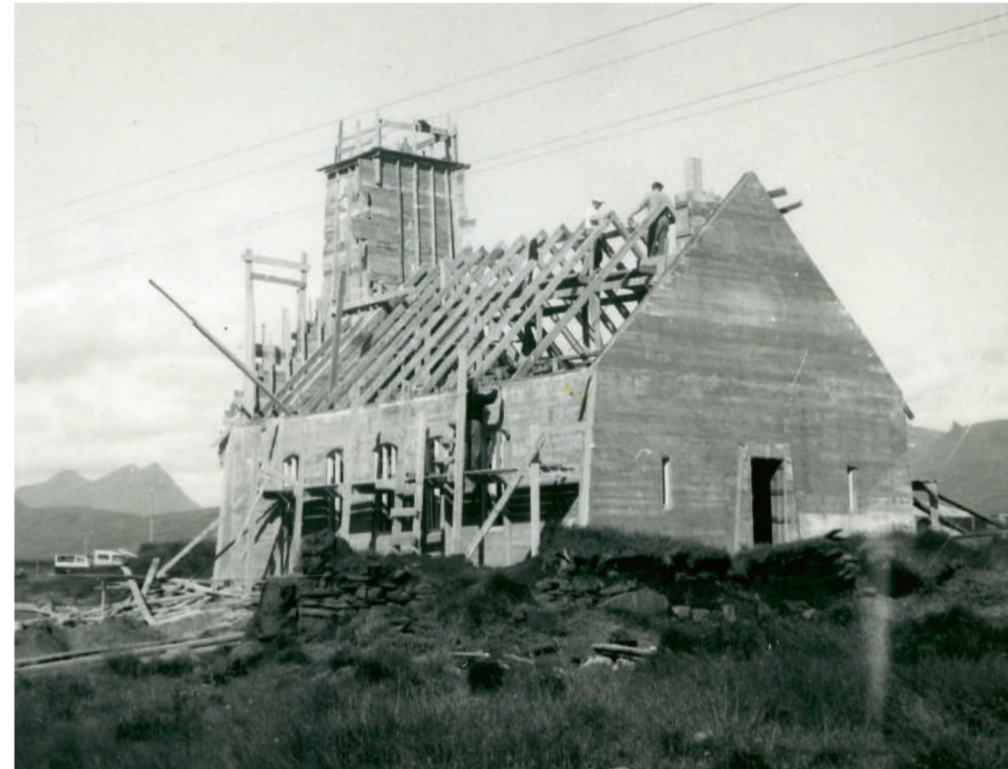
Unnið við að koma sperrum fyrir á nýju kirkjunni. Útveggir uppsteyptir, en kórinn ökominn.
